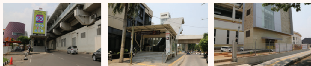
KI-ka: Stasiun LRT Boulevard Utara (depan Summarecon Mall Kelapa Gading), Stasiun LRT Boulevard Selatan (depan Klub Kelapa Gading), dan Stasiun/Depo LRT Pegangsaan Dua
